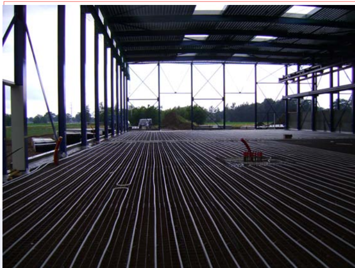
De montageklussen voor vloerverwarming, inclusief de berekeningen en het legplan, worden door AVU Klimaatbeheer zelf uitgevoerd.
